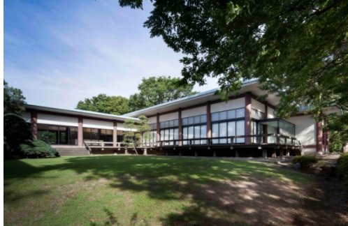
五島美術館改修 撮影：小川重雄
