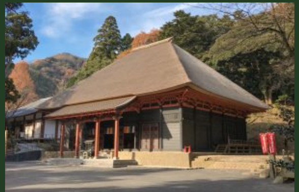
重要文化財 宝城坊（日向薬師）本堂保存修理
