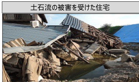
土石流の被害を受けた建築物： 構造体に大きな損傷を受け、 原則的に解体対象
