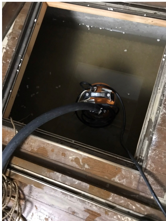
床下に溜まった水を 排水ポンプで排水している写真
