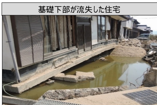
堤防決壊付近地域/埋立て地盤等：「洗堀」被害 決壊流が基礎下部に入り込み地盤を洗い流す 原則的に解体の検討対象
