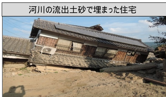
堤防決壊や河川の流出土砂で埋まる住宅。 被災家屋は、 原則として解体の検討対象
