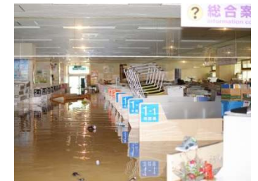
浸水した飯山市役所1階
