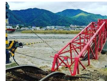
橋脚が落下した上田市別所線
