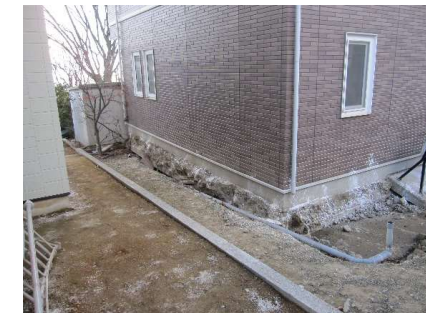
[右] 高気密住宅は室内に浸水はないが2階高さまで浸水すると浮力で基礎から浮き上がり、基礎下の土が流出して水が引くと傾いた状態となってしまう。⇒全壊として解体となる
