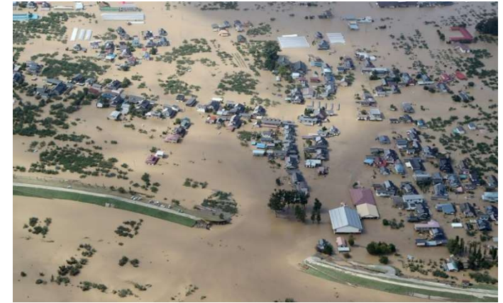
長野市長沼穂保での堤防決壊箇所
