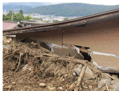
[左] 土石流により損壊した住宅
