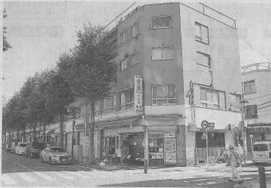
横浜の戦後復興を物語る吉田町の「防火帯建築」。エレベーターがないので4階建てで高さがそろっている。横浜市中央区
