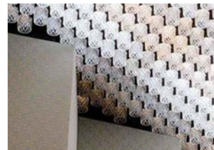
【新庁舎 議場天井】
